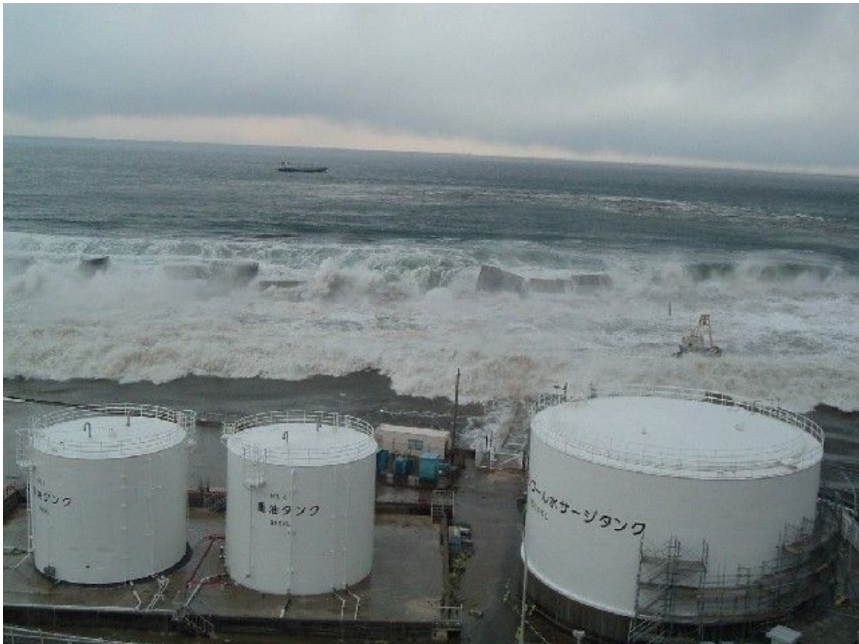
福島第一原子力発電所 津波来襲状況
