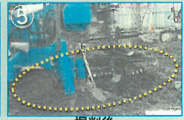
⑤ 掘削後 【H28.2.26】
