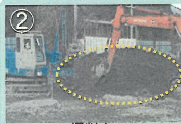
② 掘削中 【H28.2.24】
