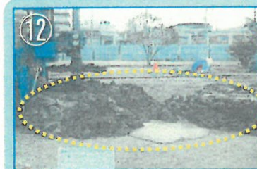
⑫ 掘削後 【H28.2.17】
